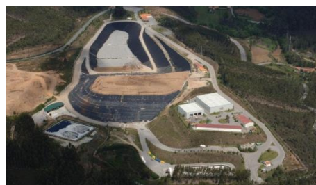
Aterro Sanitário (Cadaval)
