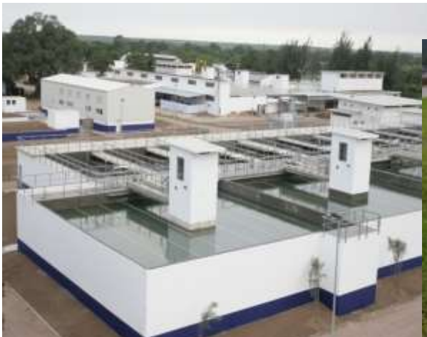
Nova Estação de Tratamento em Umbeluzi (Dez 11)
