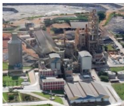
CIMPOR Unidade de CEZARINA – Clinquer 3 • Projecto Arquitectura e Engenharias • Fiscalização e Coordenação
