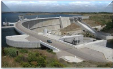
Barragem de Alqueva
