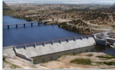
Barragem de Pedrógão
