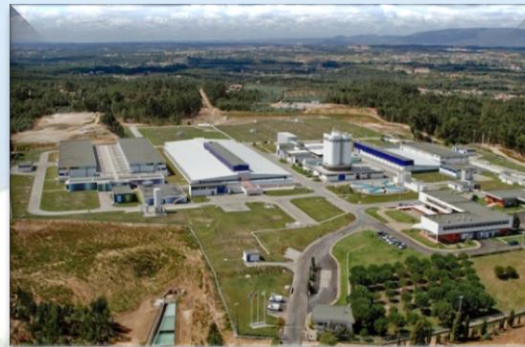
ETA da Asseiceira
