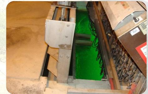
Canais UV, utilizando lâmpadas de baixa pressão e alta intensidade, com limpeza automática química e mecânica
