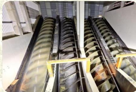
Limite máximo de elevação de  $6,6 \text{ m}^3/\text{s}$
