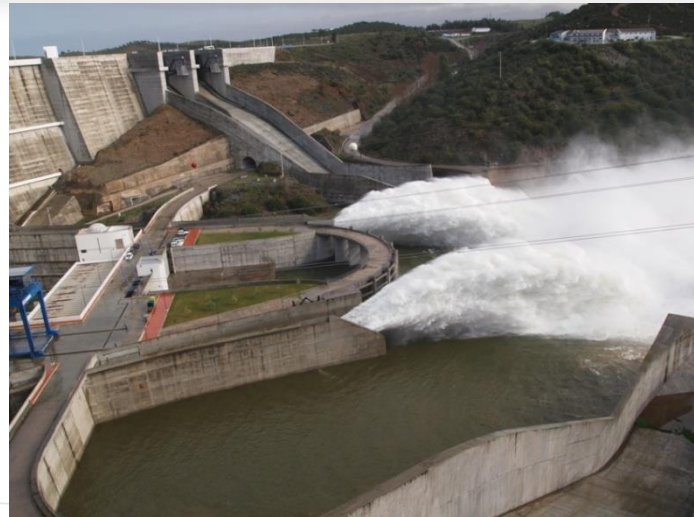
Middle Bottom Spillways
