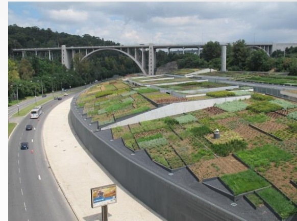
Subsistema de saneamento de Alcântara
