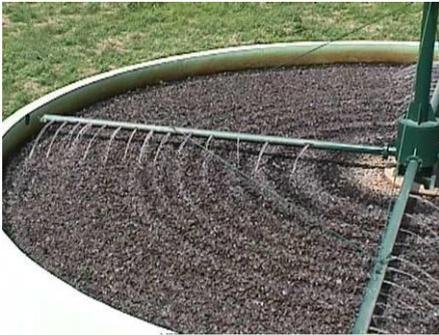
A instalação corresponde a uma linha de leitos percoladores de alta carga. As lamas são sujeitas a digestão anaeróbia a frio (na câmara de digestão do tanque Imhoff) e desidratação em leitos de secagem.
