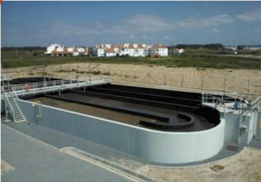
A ETAR de Vila Nova de Milfontes baseia-se num tratamento secundário por lamas activadas, operado em regime de arejamento prolongado, em 2 reactores biológicos com a configuração de vala de oxidação, com remoção de azoto, precedido de pré-tratamento constituído por tamisagem, desarenamento e remoção de gorduras, e complementado com um sistema de desinfecção por ultravioletas.
