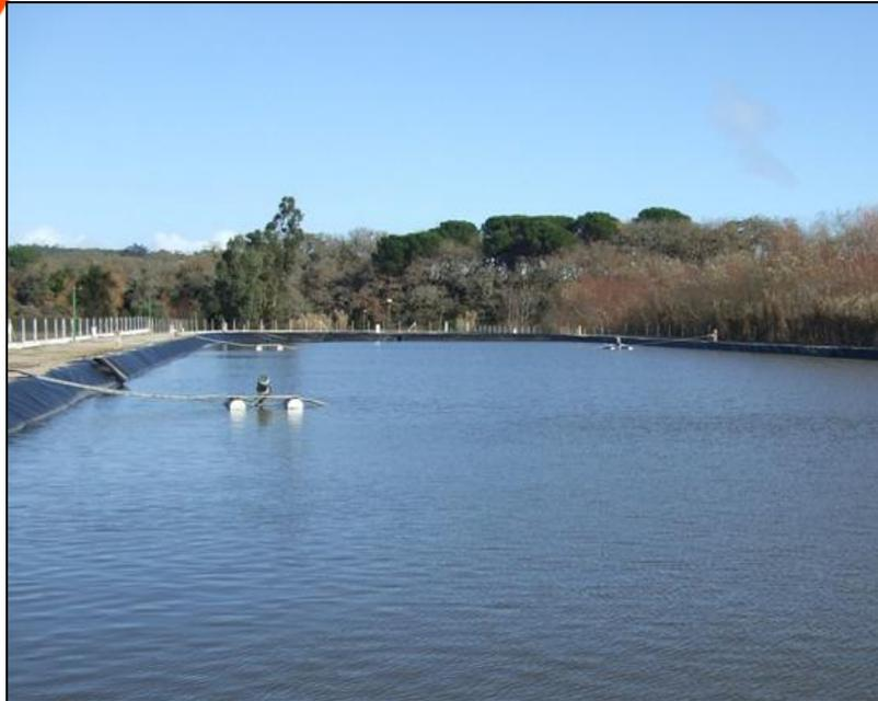
O sistema instalado corresponde a um processo de tratamento por lagunagem, constituída por duas lagoas, uma arejada e outra de decantação.
