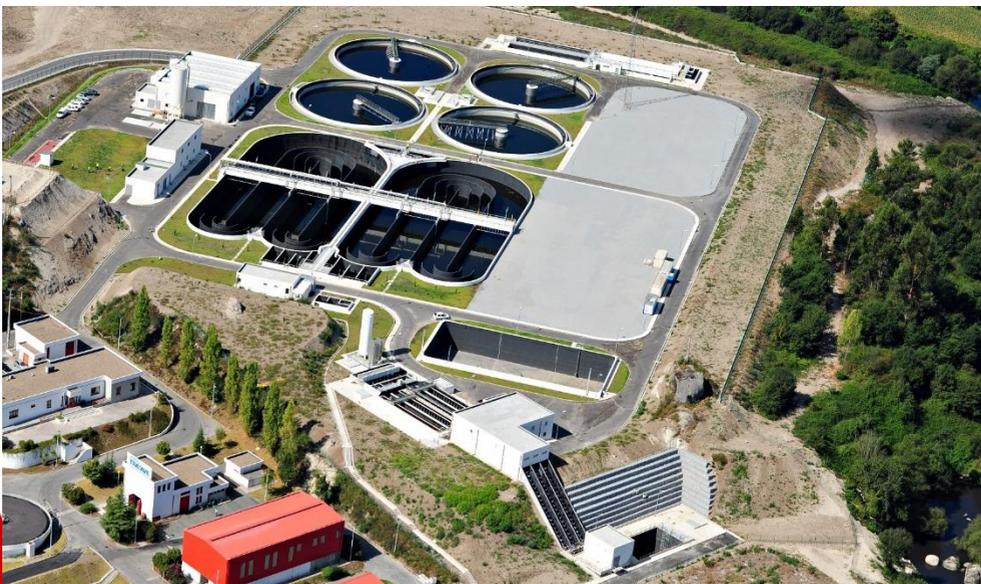
O tratamento das águas residuais é iniciado numa etapa de pré-tratamento, com correcção de pH, passando por um processo de lamas activadas, em regime de baixa carga. Segue-se o tratamento terciário de coagulação-floculação e decantação lamelar para remoção de cor e finalmente filtração e desinfecção por UV para reutilização da água tratada.
