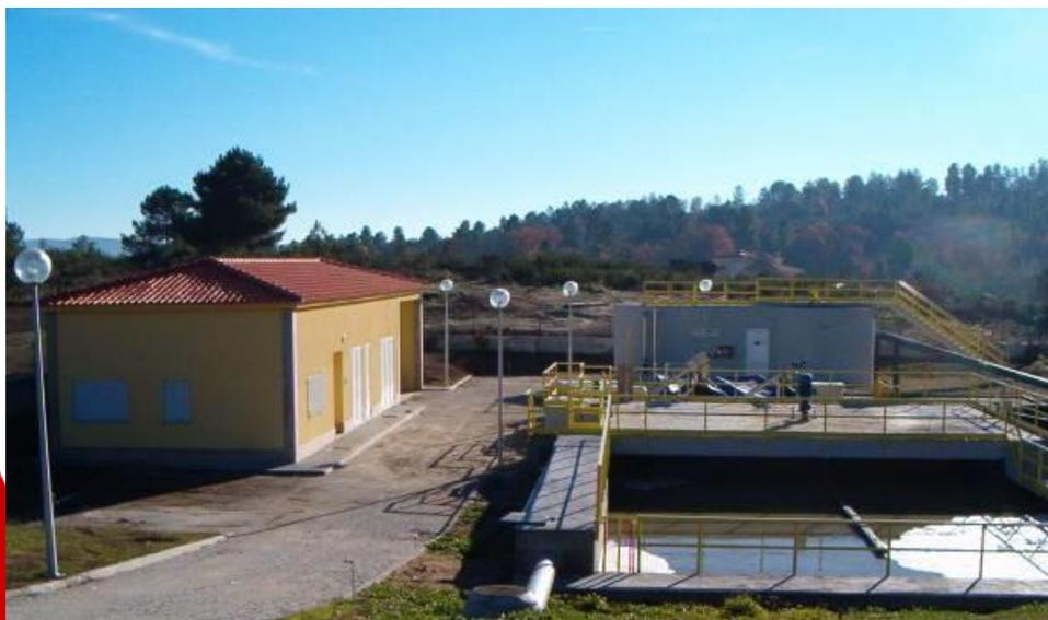
O tratamento das águas residuais é efectuado por um processo de lamas activadas, em regime de baixa carga.
