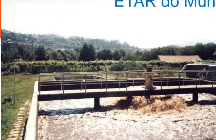
O tratamento das águas residuais é efectuado por lamas activadas, em regime de baixa carga. As lamas em excesso são desidratadas em leitos de secagem.
