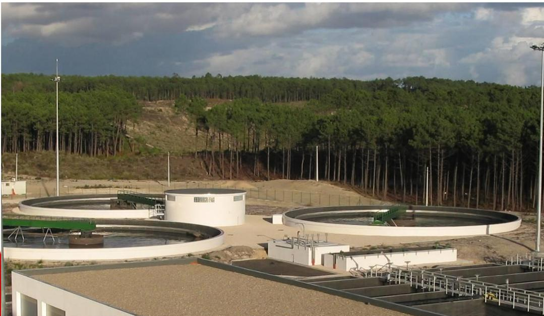
O tratamento das águas residuais é efectuado por um processo de lamas activadas, em regime de média carga, seguido de tratamento terciário com filtros de areia e desinfecção por UV.
