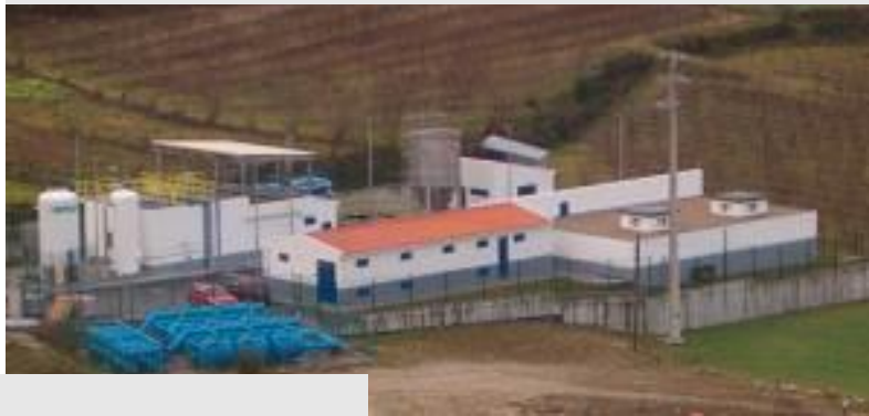
ETA de Lumières - Viseu 60m 3 /h
