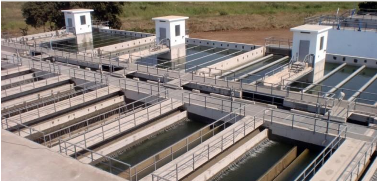
ETA de Umbeluzi Maputo MZ - 4200m 3 /h
