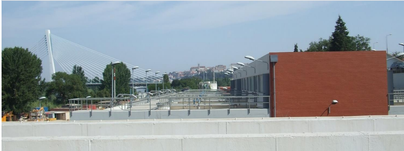
ETA da Boavista Coimbra 5400m 3 /h
