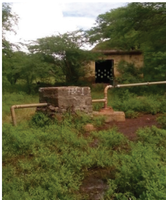
FIGURA 34 – ELECTRA SARL, FURO DA INSTALAÇÃO DE LAPA CACHORRO – FBE-1
