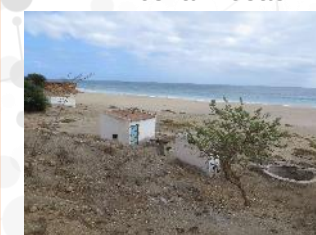
Captação Ponte Preta
