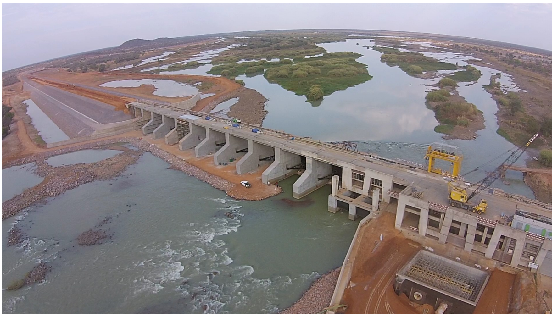
Barragem do Calueque - Estações de Bombagem
