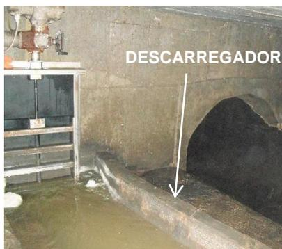
Figura 3.8 – Câmara de descarregador com comporta
