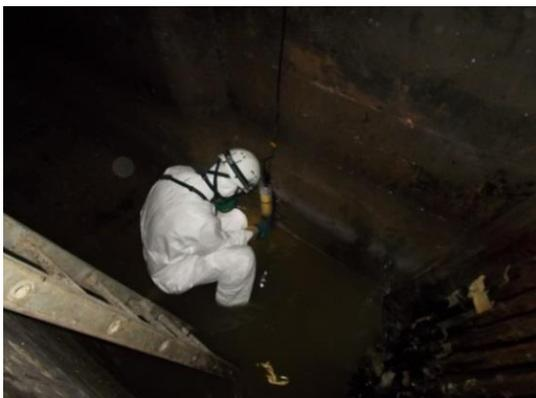
Figura 4.7 – Instalação de uma sonda de condutividade numa EE
