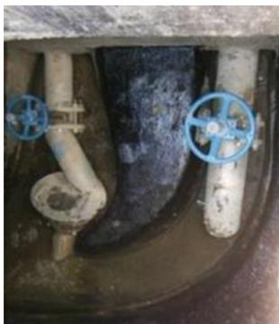
Figura 3.7– Câmara de controlo de caudal (tipo Vórtex)
