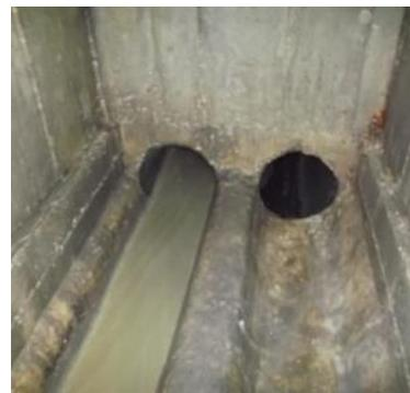
Figura 3.9 – Coletor pluvial e unitário da câmara do descarregador
