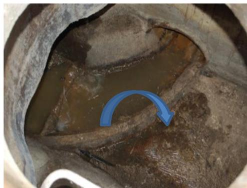
Figura 3.5 – Descarregador tipo murete em tempo seco
