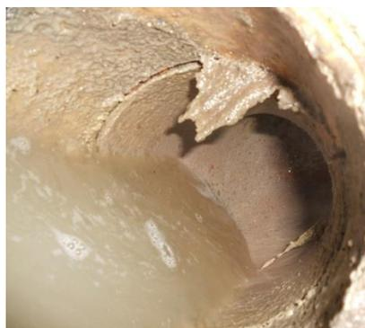
Figura 3.3 - Pormenor de intrusão de raiz na junta do coletor
