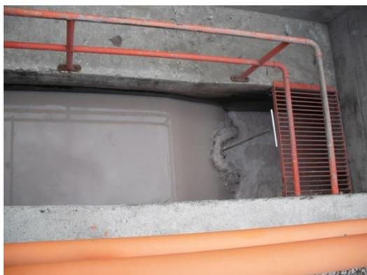
Figura 3.11 - Descarga indevida afluyente à ETAR de Beirolas
