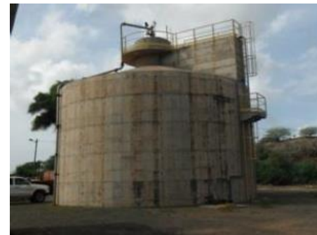
Digestor anaeróbico de lamas da ETAR de Palmarejo.
