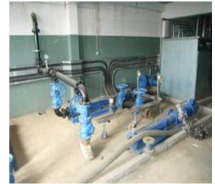
Bomba de lamas (fora de serviço) da ETAR de Palmarejo.
