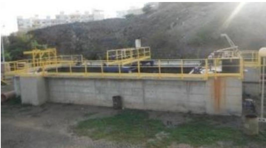
Decantadores primários da ETAR de Palmarejo.
