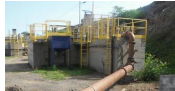
Obra de entrada (gradagem e desarenação) da ETAR de Palmarejo.
