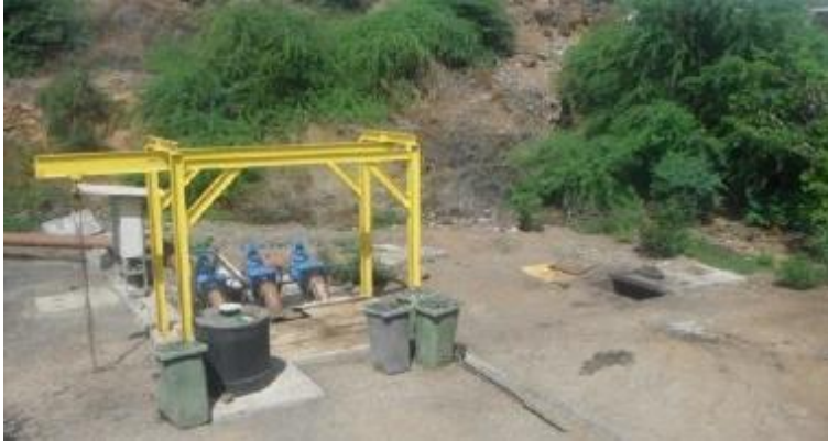
Estação elevatória inicial da ETAR de Palmarejo.
