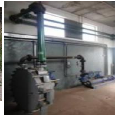
Bomba helicoidal P805 e permutador de calor Y801 da ETAR de Palmarejo.
