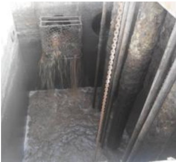
Estação elevatória inicial e equipamentos da ETAR de Palmarejo.
