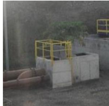
Câmara de distribuição de caudal da ETAR de Palmarejo.
