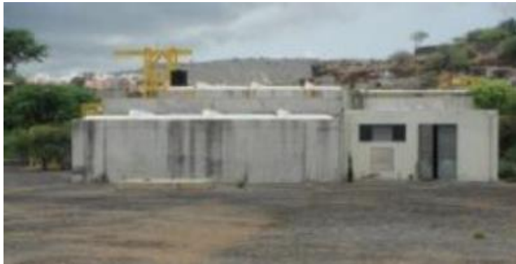
Tanque de armazenamento e espessamento de lamas da ETAR de Palmarejo.
