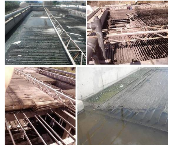
Lamelas dos compartimentos T502 e T503 da ETAR de Palmarejo.
