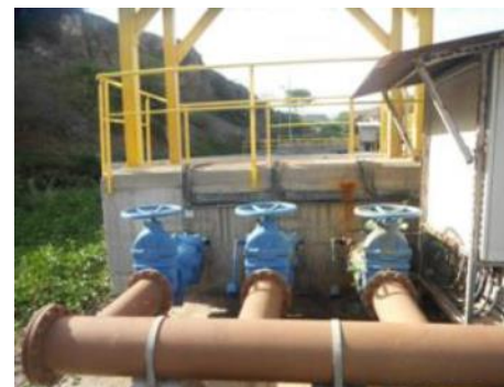
Estação elevatória do efluente dos decantadores primários da ETAR de Palmarejo.
