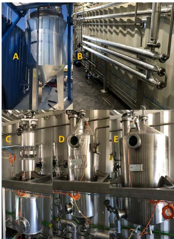
Figura 6. Equipamentos que constituem o sistema de pré-tratamento de lamas. A - Depósito pulmão, B - Permutador de calor tubular, C - Esterilizador, D - Reservatório Flash 1, E - Reservatório Flash 2.
