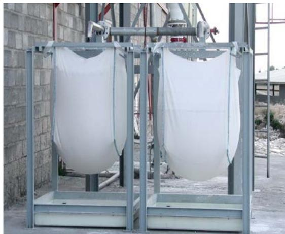
Figura 1. Imagem de sacos filtrantes usados para acondicionar lamas de ETAR (www.miraplas.com).
