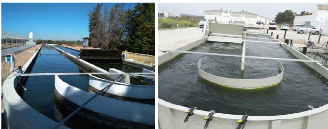
Figura 12 - HRAP de 116 m<sup>3</sup> localizado nas instalações do CENTA, Carrión de los Céspedes (Sevilha), e HRAP piloto de 6 m<sup>3</sup> localizado nas instalações de CUPIMAR, Puerto Real (Cádiz)
