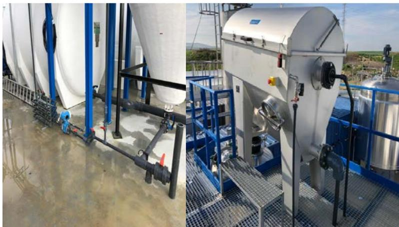
Figura 4. Tubo floculador; B. Peneira de tambor rotativo sobre passadiço elevado
