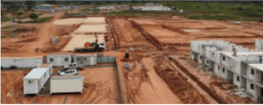
As empreitadas contemplam não só a construção da rede de infraestruturas internas da Centralidade, mas também a construção das infraestruturas externas de acesso viário, sistema de abastecimento de água potável, sistema de tratamento de águas residuais e sistema de abastecimento de energia elétrica. Os equipamentos sociais desta Centralidade incluem um Posto de Saúde, um Jardim de Infância, um Centro Infantil, uma Escola Primária, uma Escola Secundária e um Posto de Polícia.
