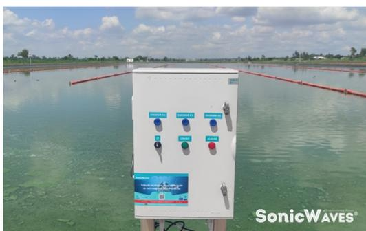
A Environmental Waves instalou equipamentos SONICWAVES nas lagoas de maturação da ETAR de Infulene, em Maputo, para prevenir o boom de microalgas. Esta instalação realizou-se enquadrada na obra de reabilitação da ETAR de Infulene, dimensionada para 128 mil habitantes equivalentes.
